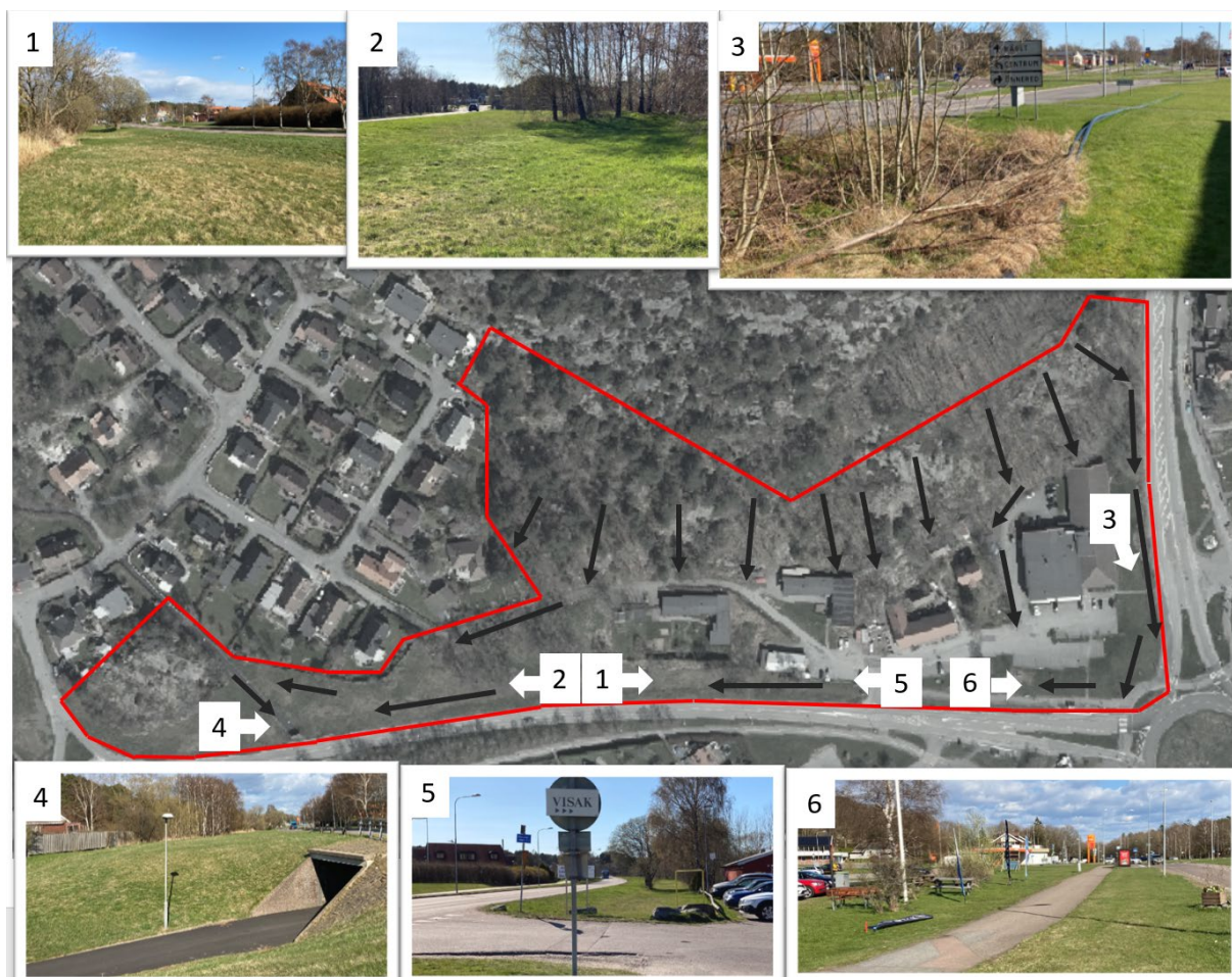
Figur 3. Röd linje visar tidigare version av planområdet. Bild 1–6 visar planområdet ur olika vinklar. Vit pil visar åt vilket håll bilden är tagen. Svarta pilar redovisar riktning på ytavrinning. Fotograf Anna Germundsson, Kretslopp och vatten.
