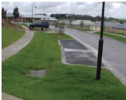
Figur 14. Bild t.v. exempelbild på svackdike. Källa Luleå tekniska universitet. Bild t.h. tvärsnitt av svackdike.
